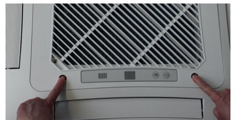
Bild 14: Verriegelung: Baugrößen 24 bis 42 (oben) Baugrößen 12, 18 und 48 (unten)
